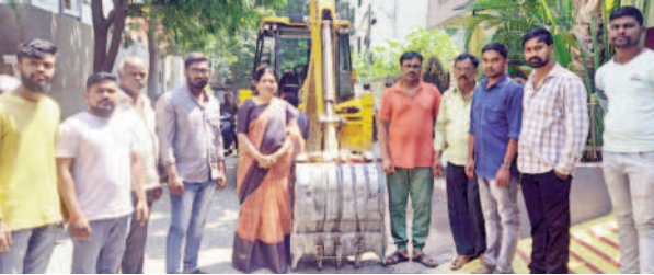
సిసి రోడ్డు నిర్మాణ పనులను ప్రారంభిస్తున్న కార్పొరేటర్ భాగ్యలక్ష్మి
